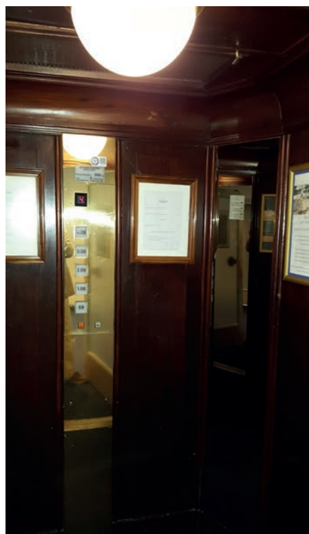
Kabine von innen mit Bedienelement
